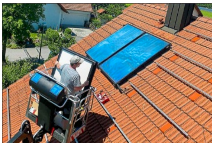
Einer der Schwerpunkte ist die Montage von Photovoltaikanlagen.
