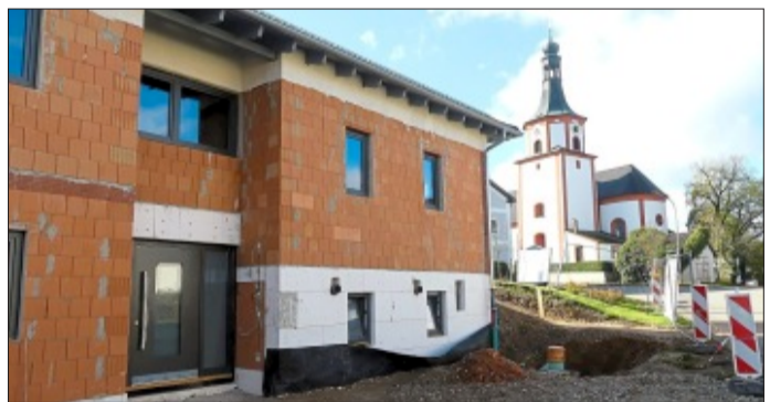
Die Bauarbeiten am Feuerwehrhaus im Breitenbrunner Ortsteil Kemnathen schreiten zügig voran. Foto: Sturm
