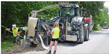
Hier wird das neue Verfahren für den Einbau von Glasfaserleitungen angewendet.
