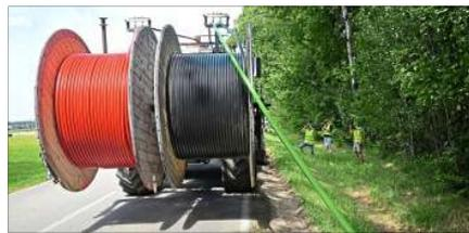
Zwei Glasfasertrömmeln sind am Frästraktor angebracht. Im Nachgang wird die Fräschneise direkt geschlossen. Fotos: Tino Lex
