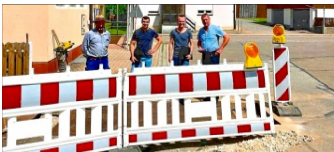
Bürgermeister Andreas Beer besichtigt die Kanalsanierung, mit dabei als EBB-Fachbereichsleiter Michael Kuchenreuter und Mitarbeiter der Firma Tausendpfund (von rechts). Foto: Monika Bucher
