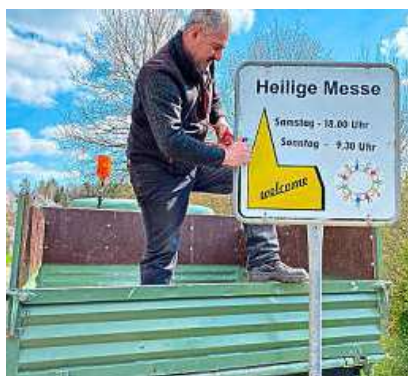
Der Unimog 406 als Arbeitsbrücke zur Montage der neuen Gottesdienst-Hinweisschilder.
